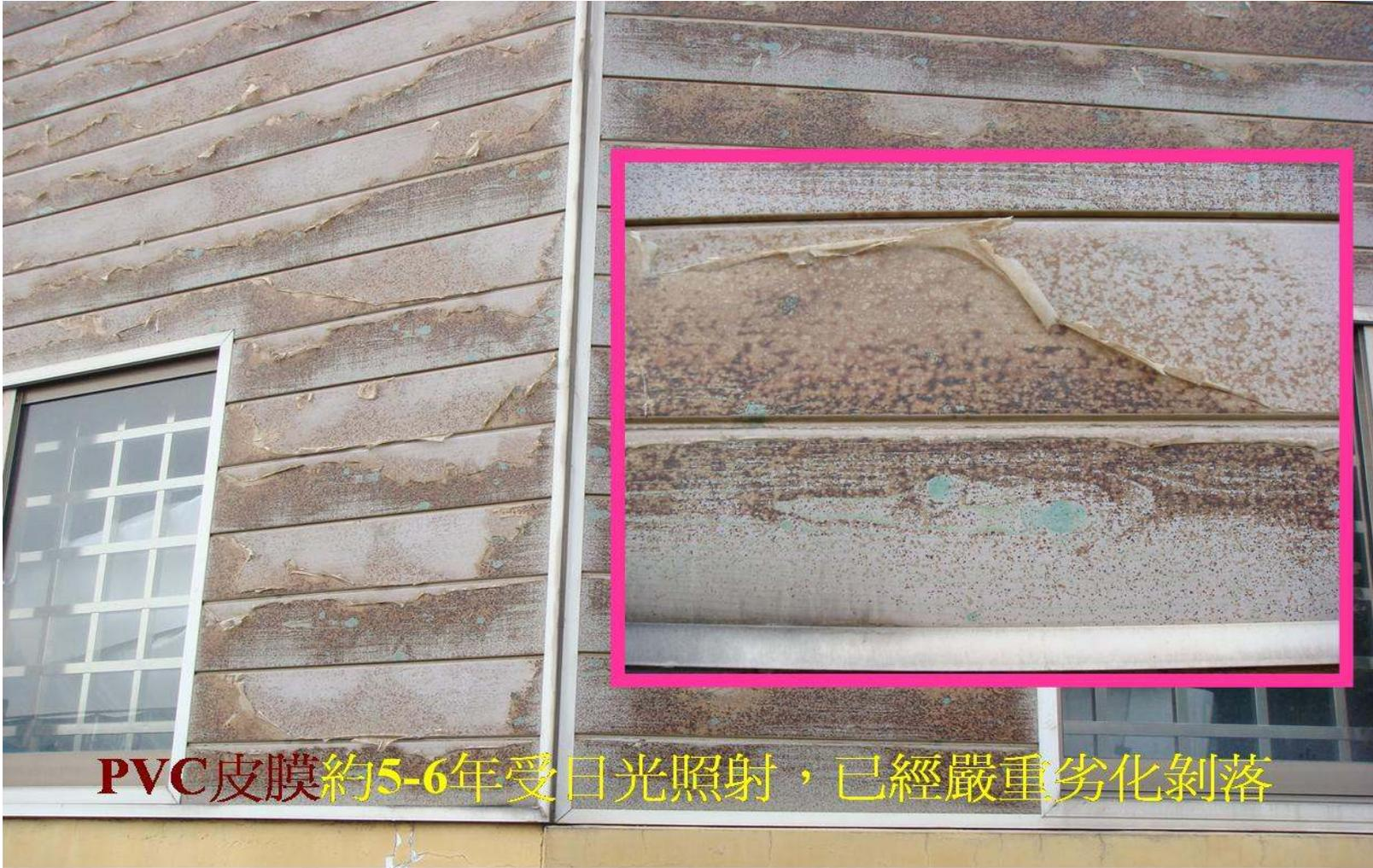
**PVC皮膜約5-6年受日光照射，已經嚴重劣化剝落**
